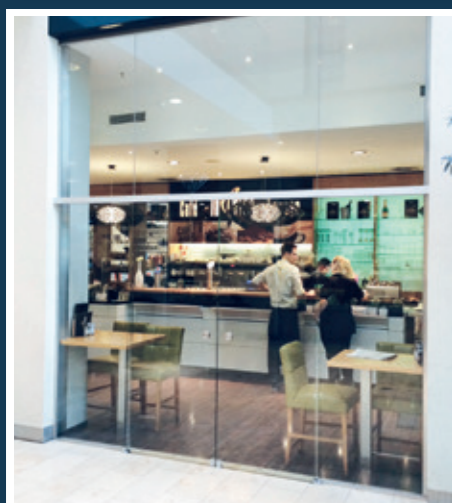
Ganz-Glas-Fassade mit integrierter zweiflügeliger Schiebetür-Anlage mit automatischer Einzugsmechanik
