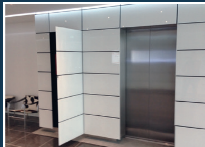
Farbige Glaswände mit integrierter Technik-Tür, flächenbündig
