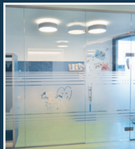
Glas-Trennwand mit gestaltetem Sichtschutzbereich
