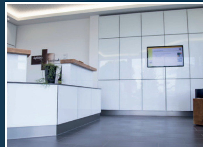
Anmelde-Tresen und Schrankwand-Anlage mit aufkaschiertem weiß beschichtetem Glas sowie eingelassenem Info Center
